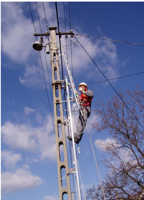
72. Záró elem felszerelése
