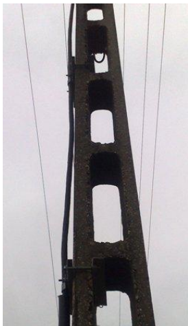
103. Normál áttörésű oszlop (Az áttörés mászható méretű!)
