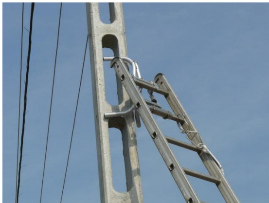
87. A létra felső részére szerelt támasztószervezet
