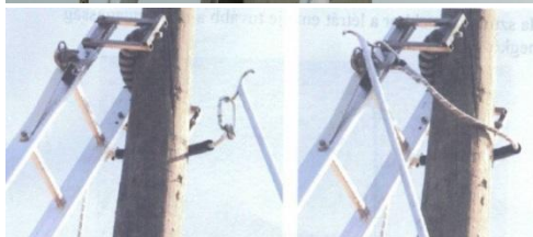
90.-91. Felső rész kötélhurkos rögzítése
