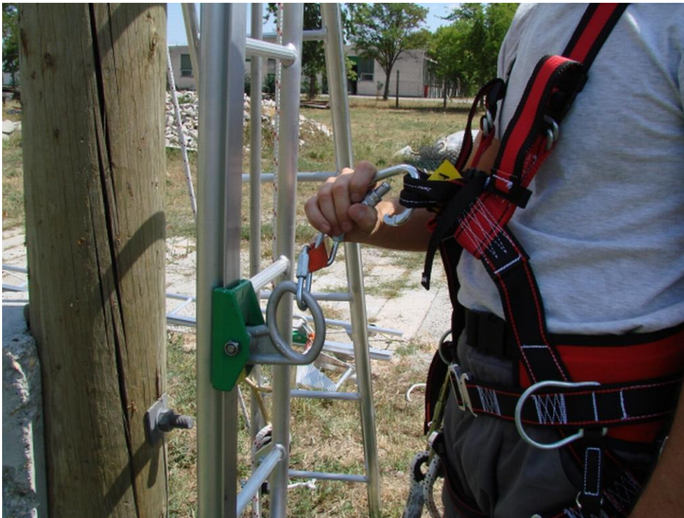
20. TE.M.A. létrára rendszeresített zuhanásgátló
