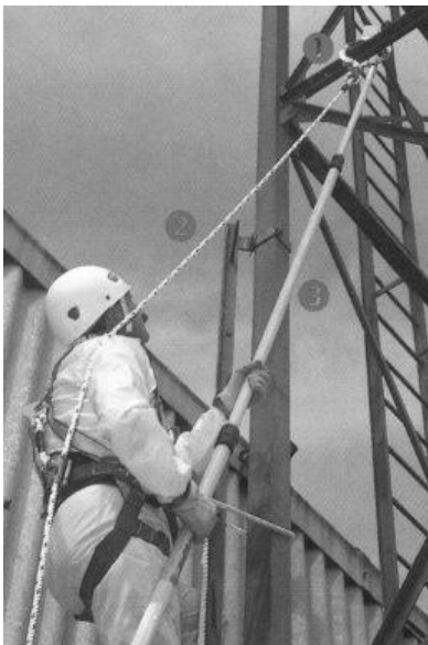
21. Vezető kötélnél felrakása felrakó rúddal
