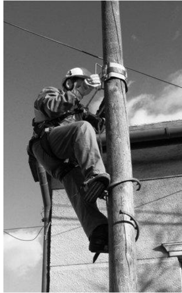
100. Mászás mászó szerszámmal, gyűrűs biztosítással
