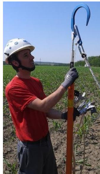
22.-23. Vezető kötélnél zuhanás gátlóval, kezelőrúddal
