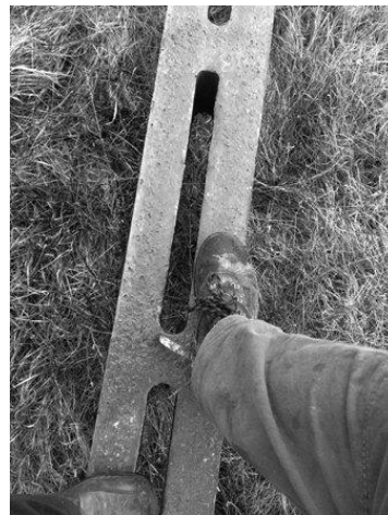
104. Szűkített áttörésű oszlop (Az áttörés nem mászható méretű!)
