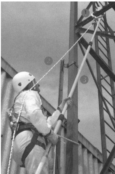
21. Vezető kötélnél felrakása felrakó rúddal
